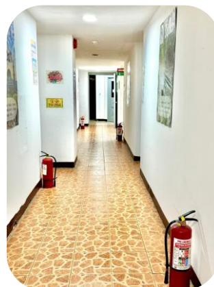
各建物廊下内に 消火器を設置
